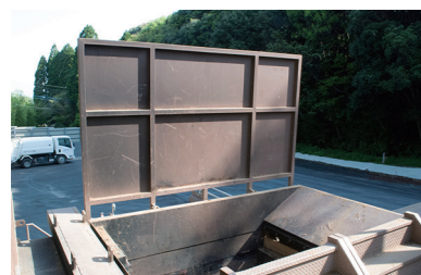
■ 投入口扉開 投入部容積 (長さ)2,000×(高さ)860×(幅)1,000=1.72m³
